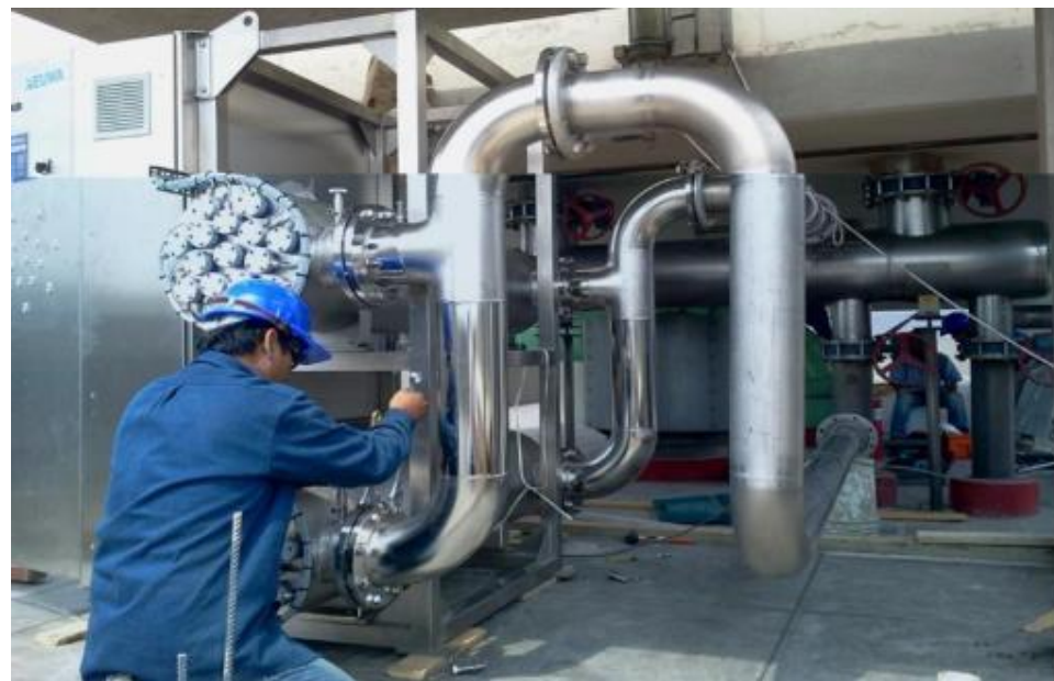
MONTAJE DE OZONIZACIÓN Y UV - BACKUS ATE
